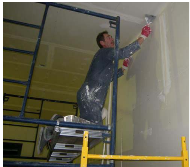
Gil Bourrier drywall taping
